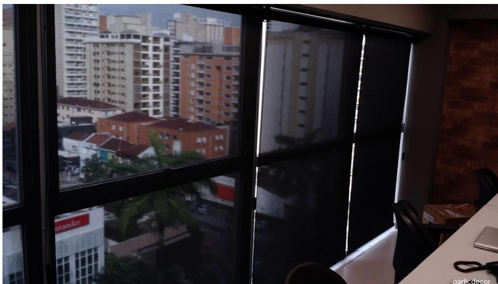
Figura 4 – Imagem ilustrativa da cortina screen instalada
