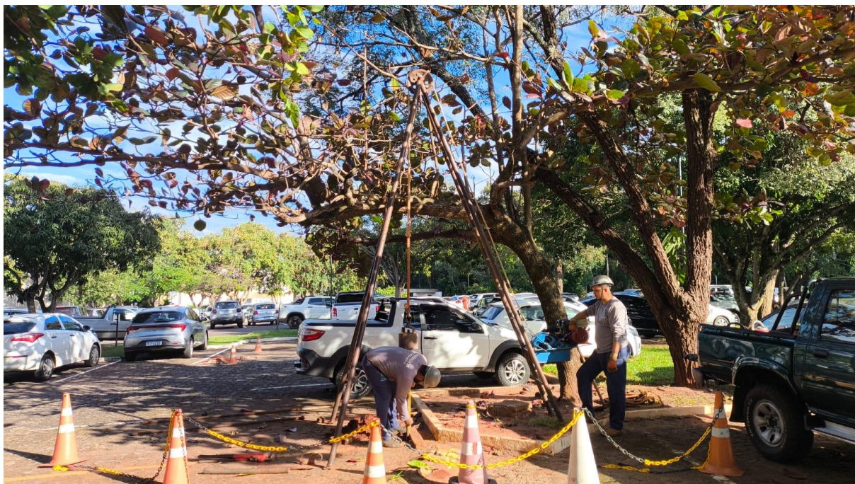
Figura 106 – Execução de sondagem SPT-18
