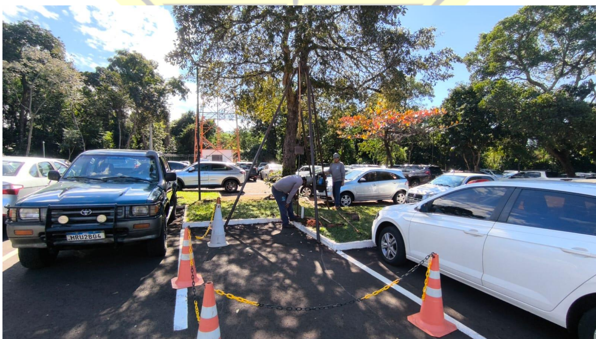
Figura 129 – Execução de sondagem SPT-21
