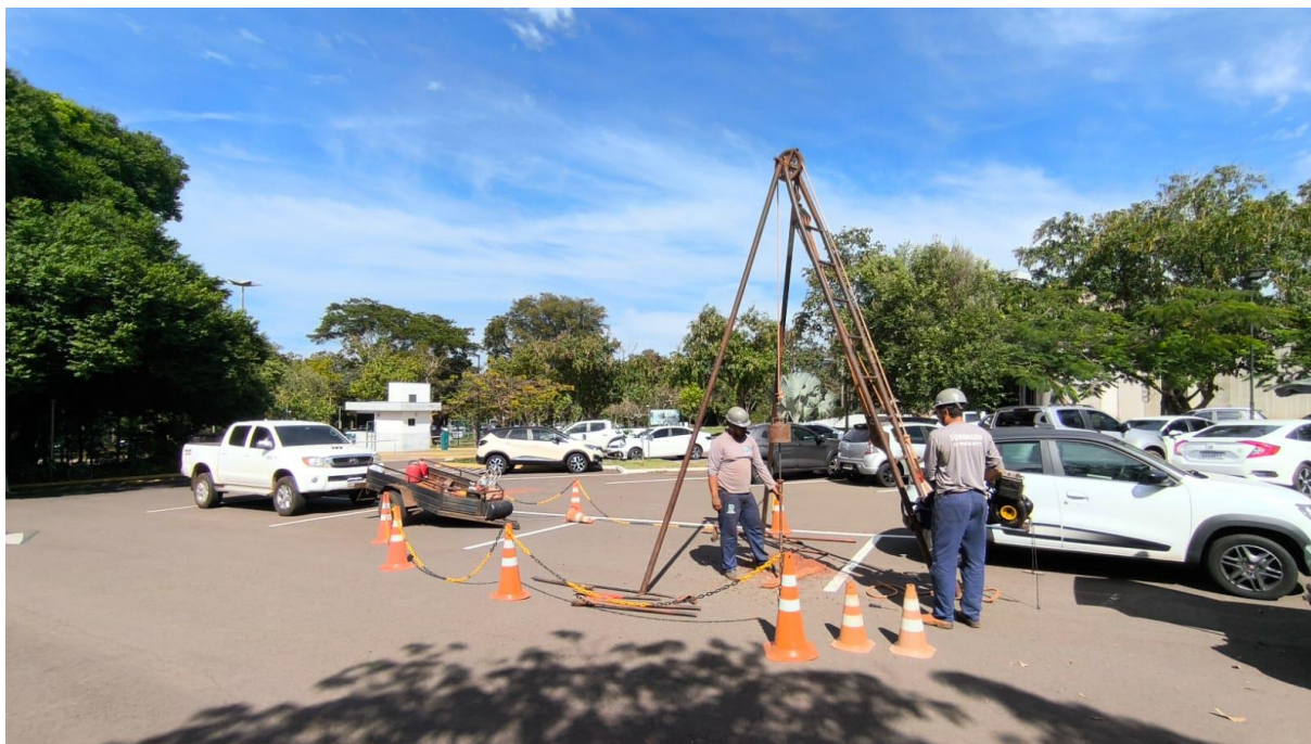
Figura 58 – Execução de sondagem SPT-11
