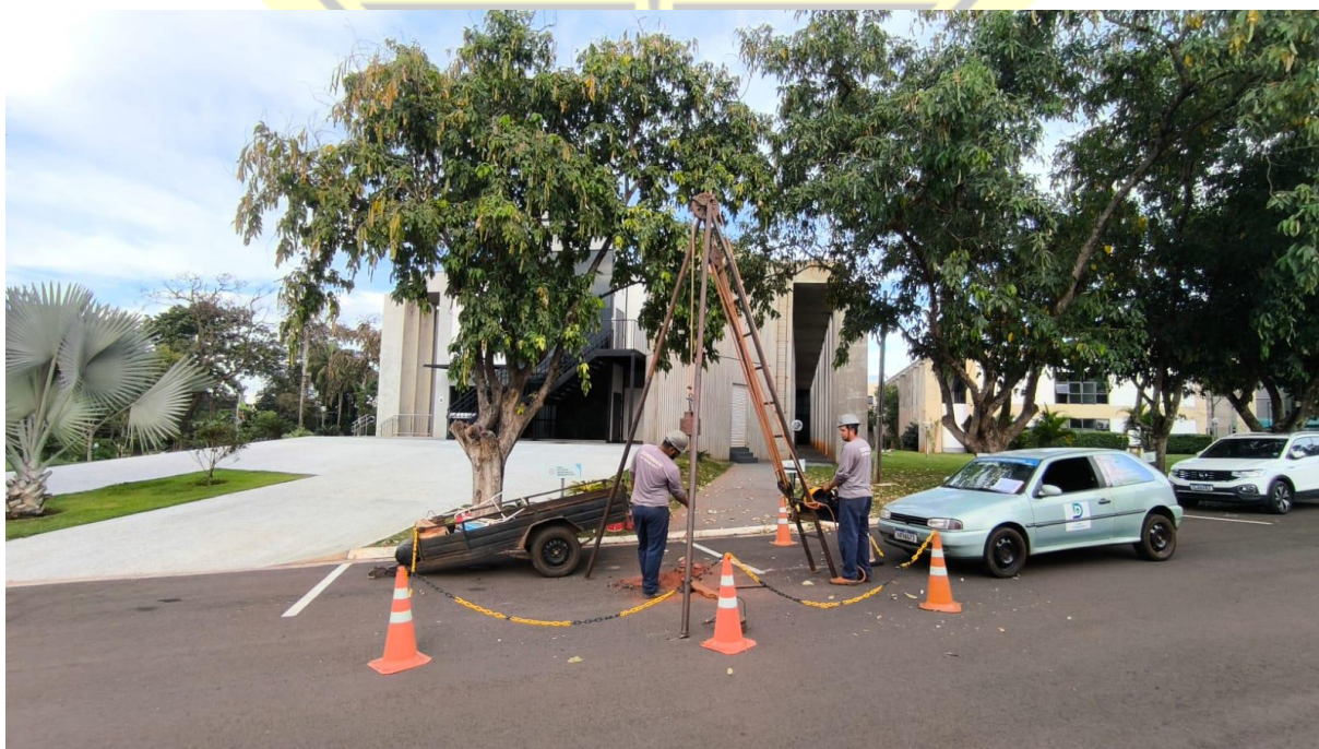
Figura 45 – Execução de sondagem SPT-09
