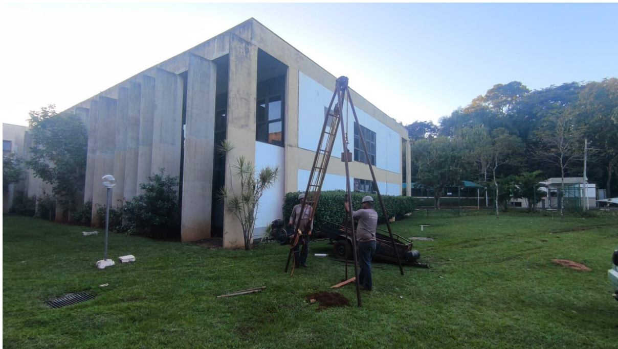
Figura 2 – Execução de sondagem SPT-03
