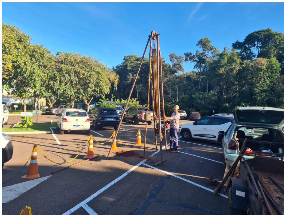
Figura 64 – Execução de sondagem SPT-12
