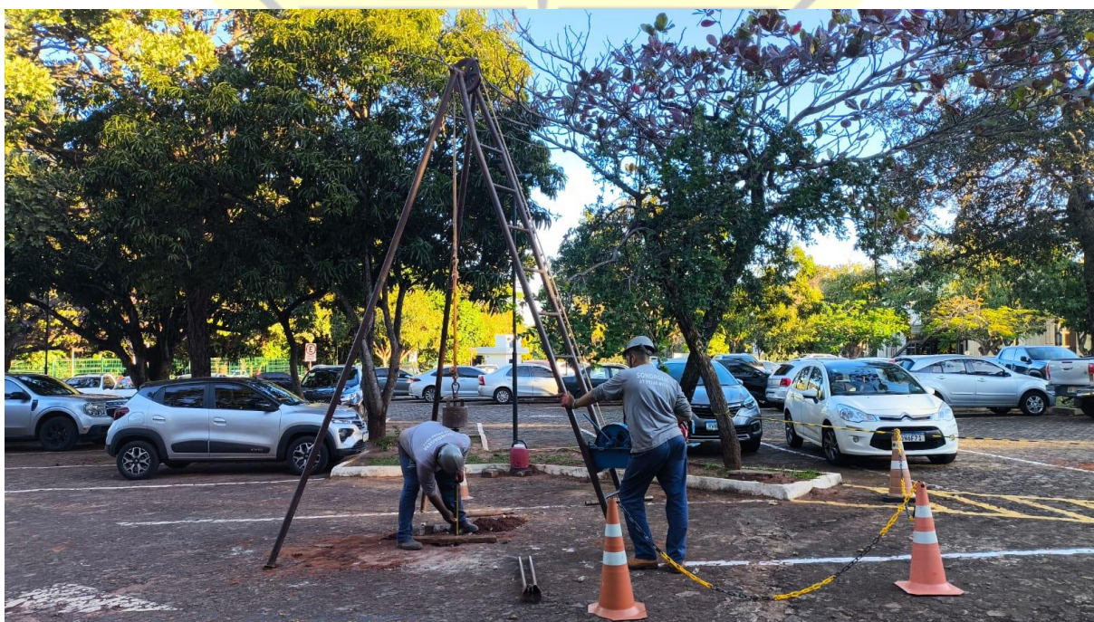
Figura 85 – Execução de sondagem SPT-15
