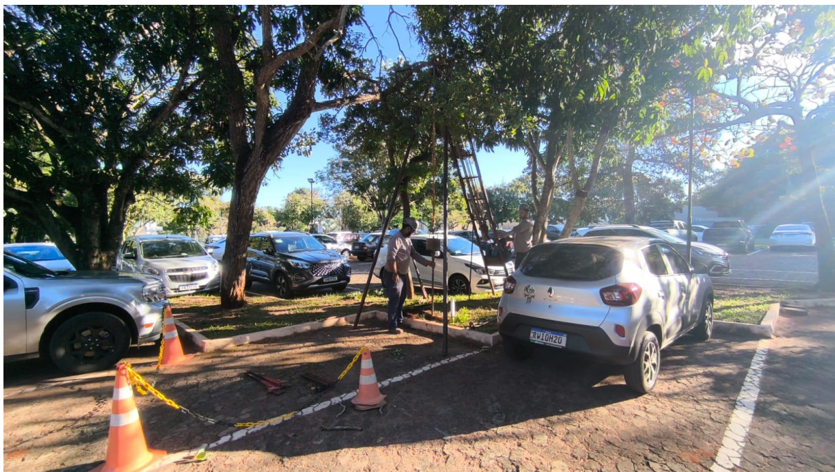
Figura 94 – Execução de sondagem SPT-16
