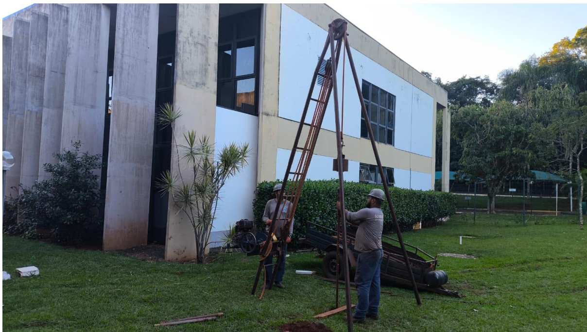
Figura 4 – Execução de sondagem SPT-03
