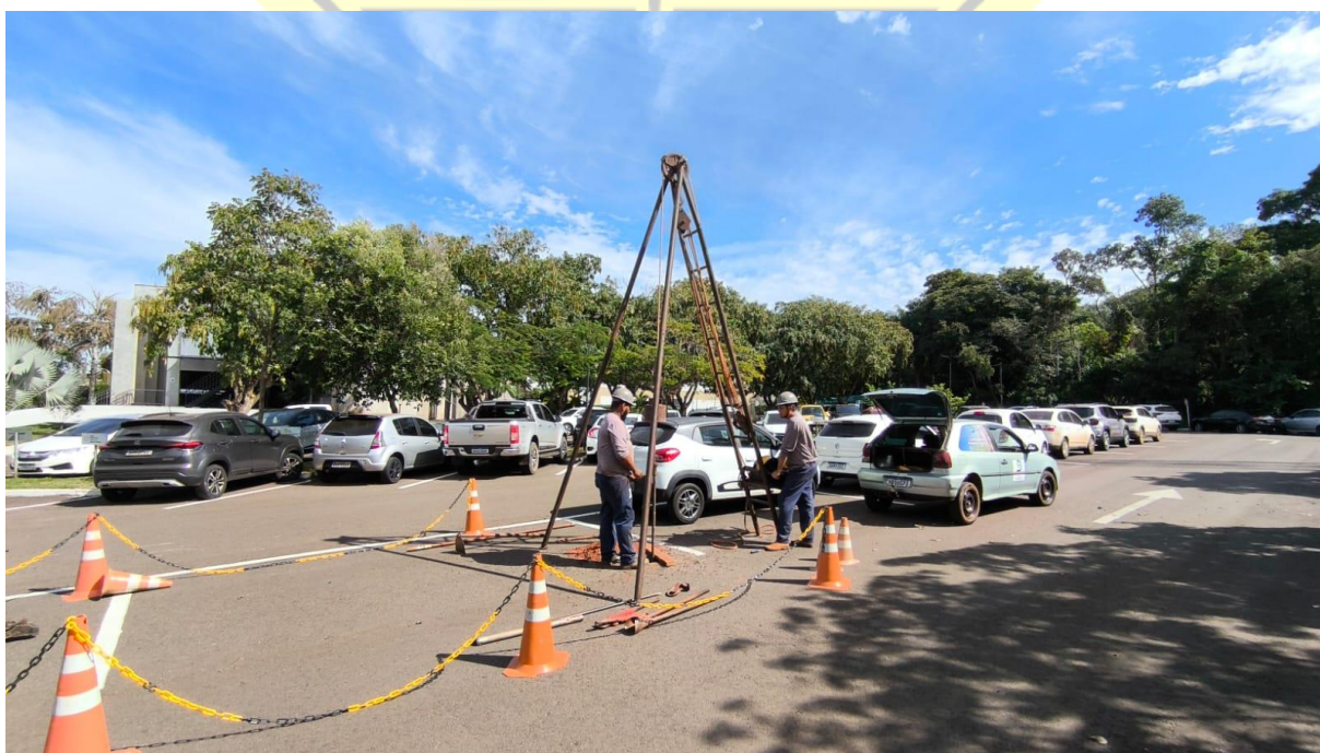
Figura 57 – Execução de sondagem SPT-11
