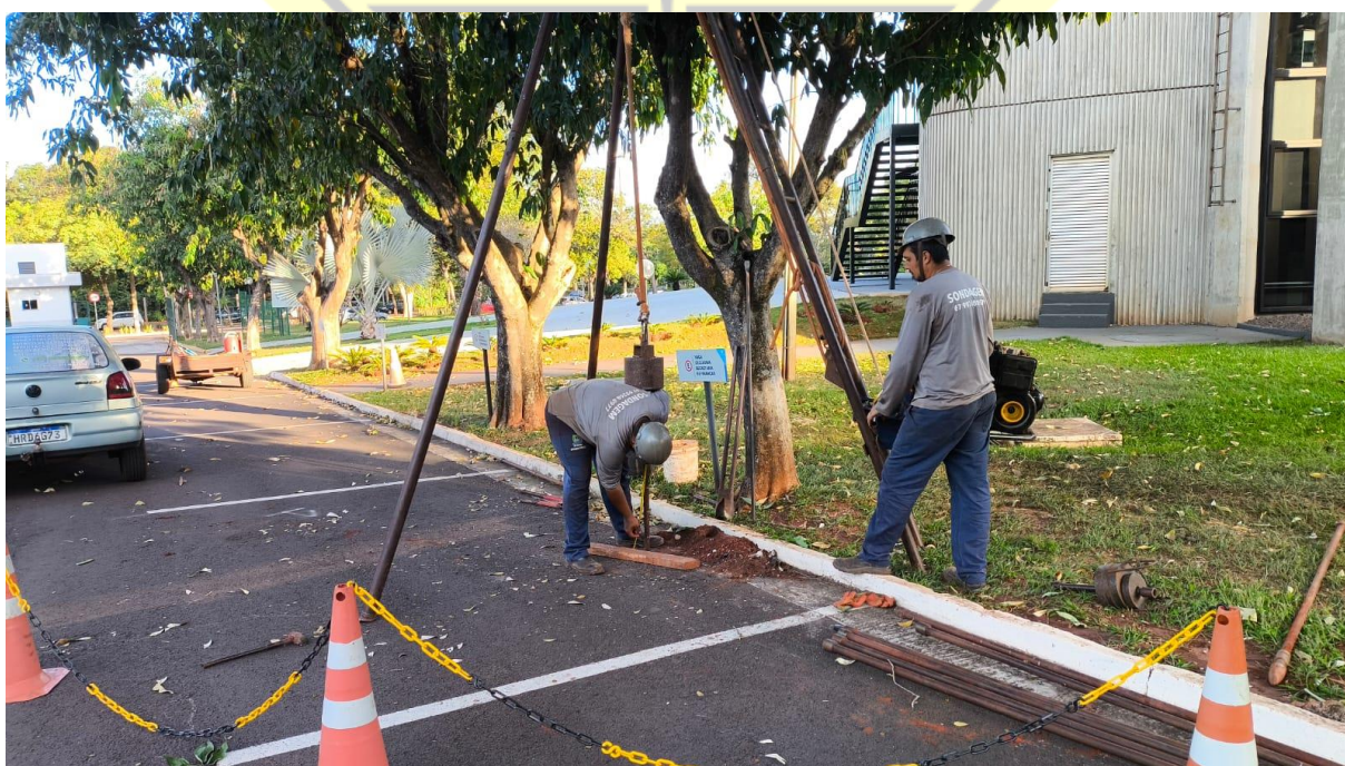
Figura 37 – Execução de sondagem SPT-08
