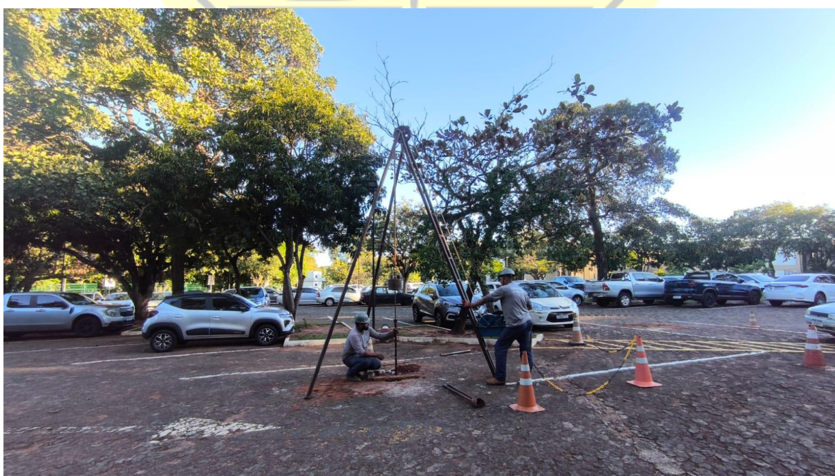
Figura 87 – Execução de sondagem SPT-15
