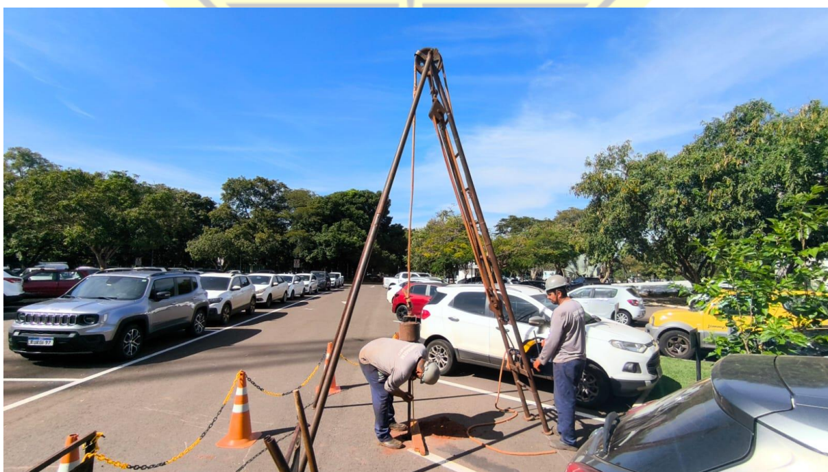
Figura 23 – Execução de sondagem SPT-06
