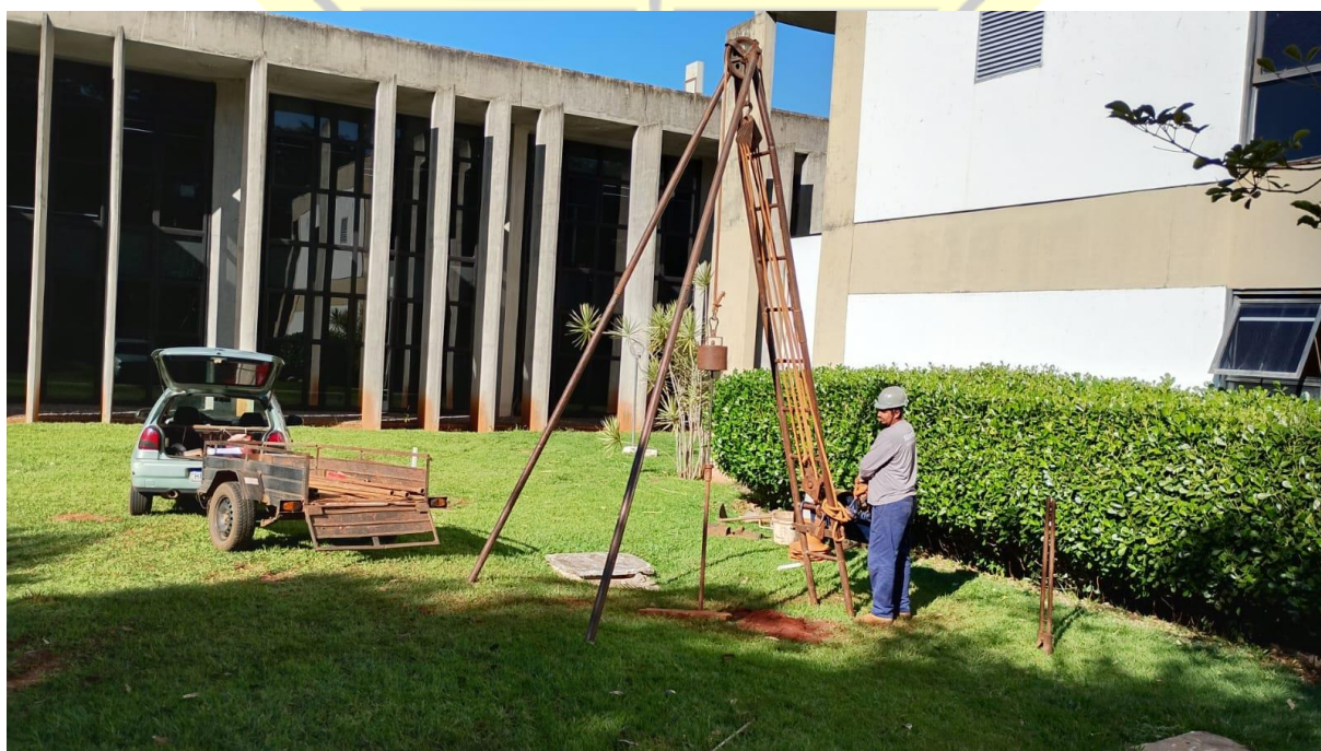
Figura 9 – Execução de sondagem SPT-04
