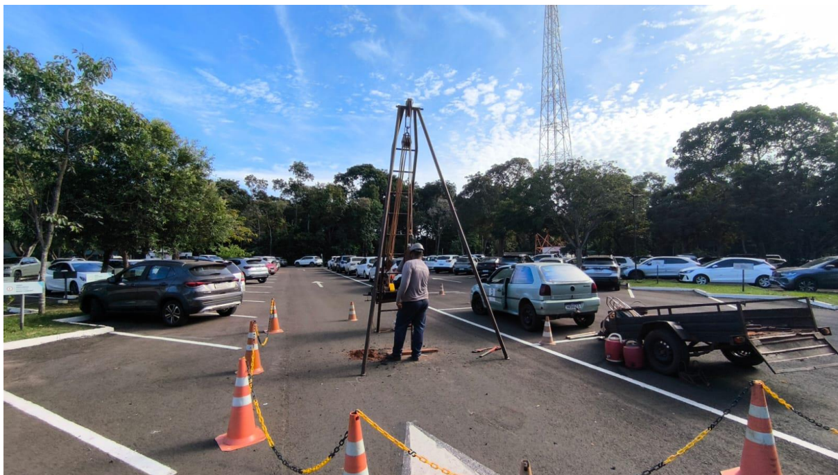
Figura 50 – Execução de sondagem SPT-10
