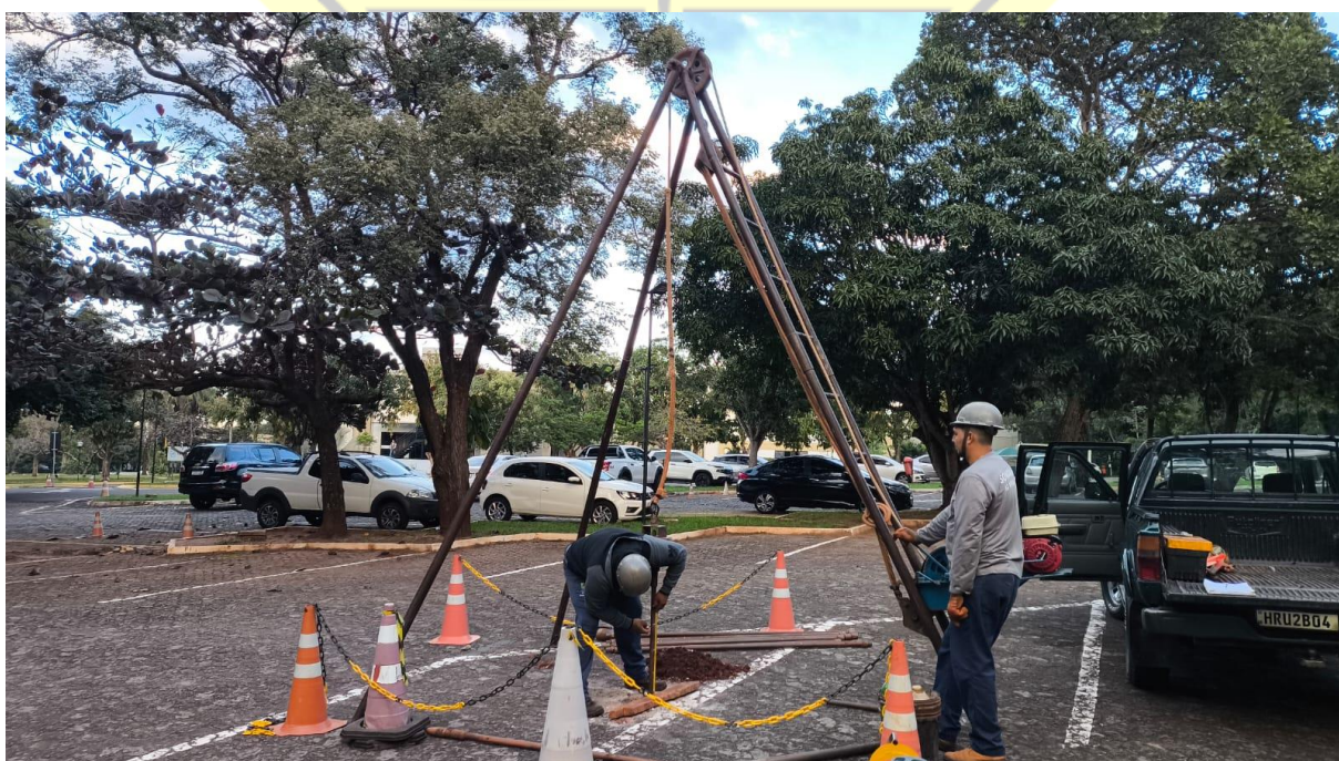
Figura 101 – Execução de sondagem SPT-17
