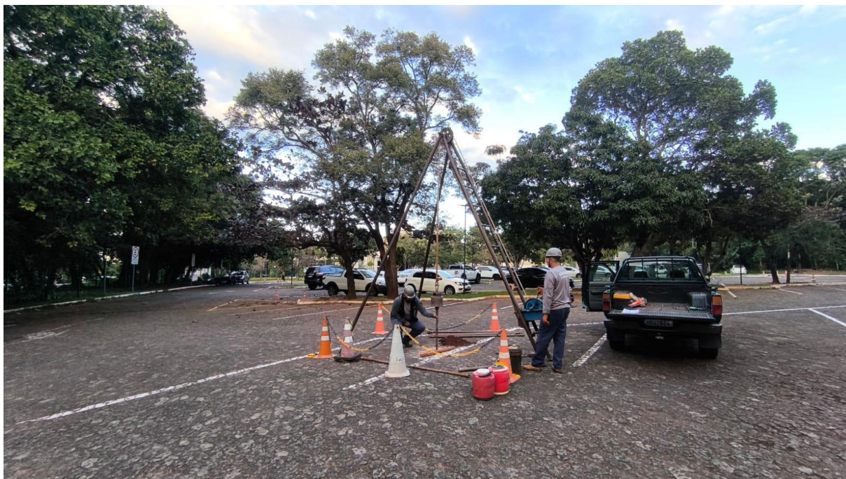
Figura 100 – Execução de sondagem SPT-17
