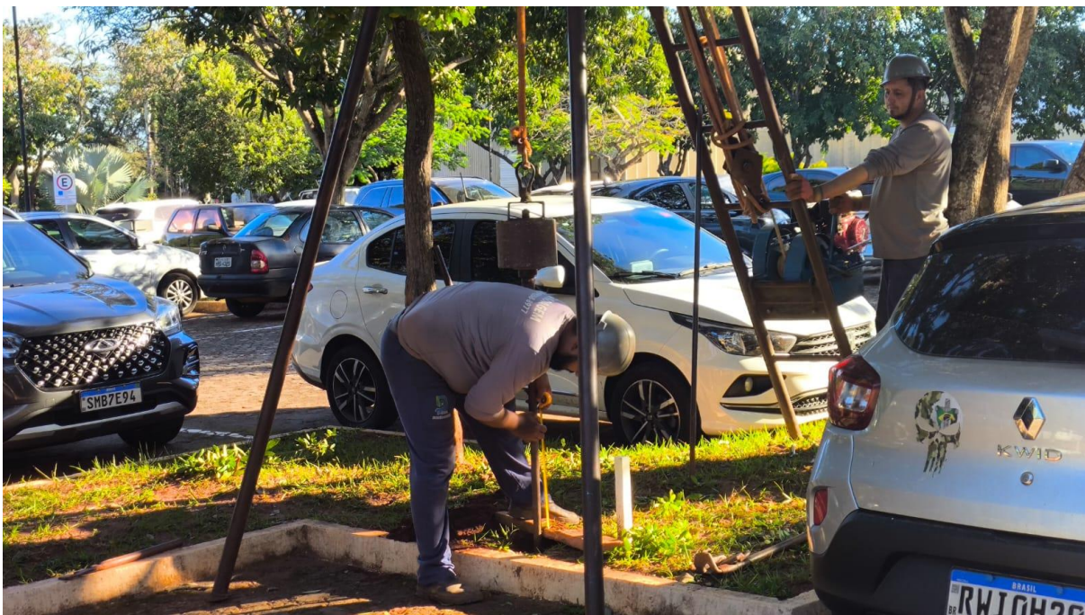
Figura 92 – Execução de sondagem SPT-16
