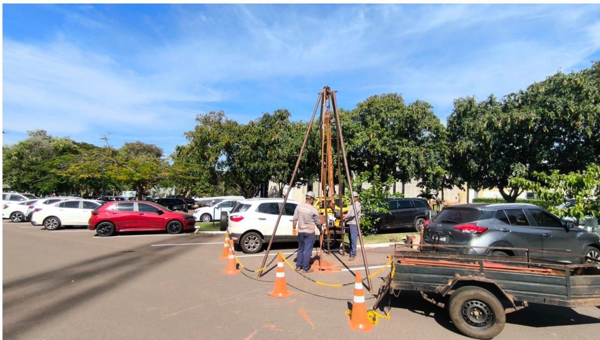
Figura 22 – Execução de sondagem SPT-06
