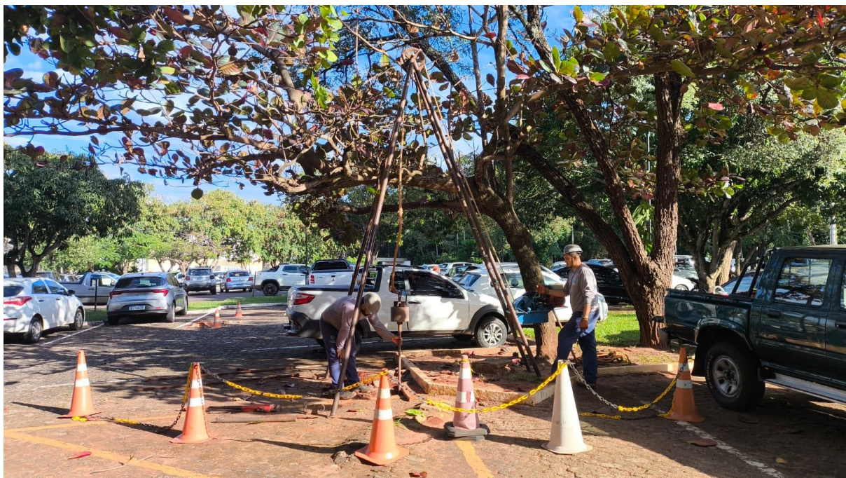
Figura 108 – Execução de sondagem SPT-18
