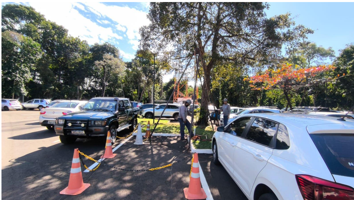
Figura 128 – Execução de sondagem SPT-21
