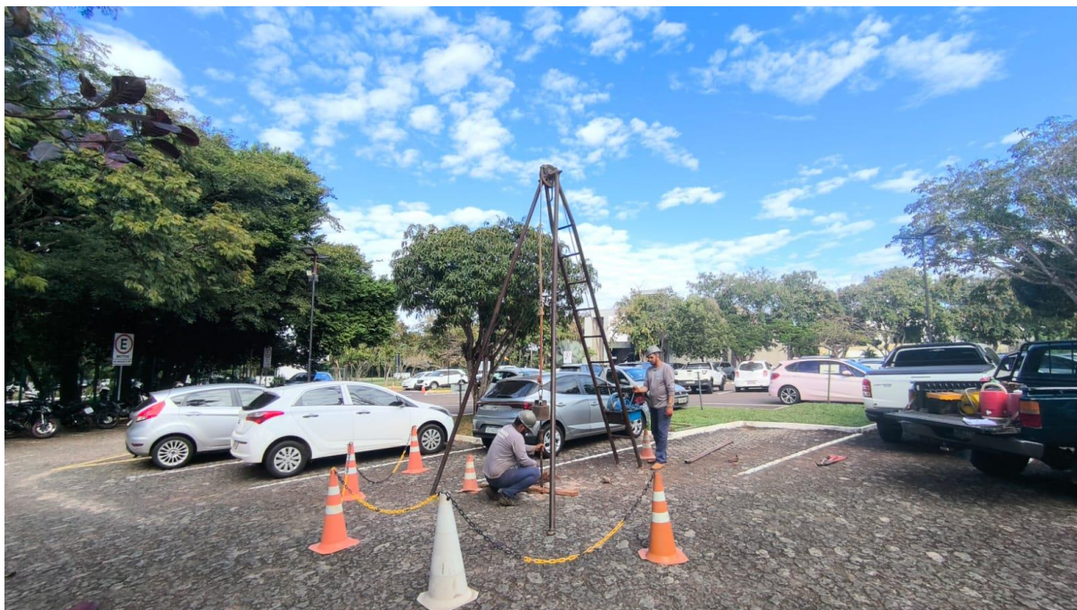
Figura 114 – Execução de sondagem SPT-19
