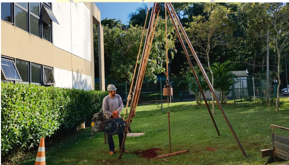
Figura 17 – Execução de sondagem SPT-05
