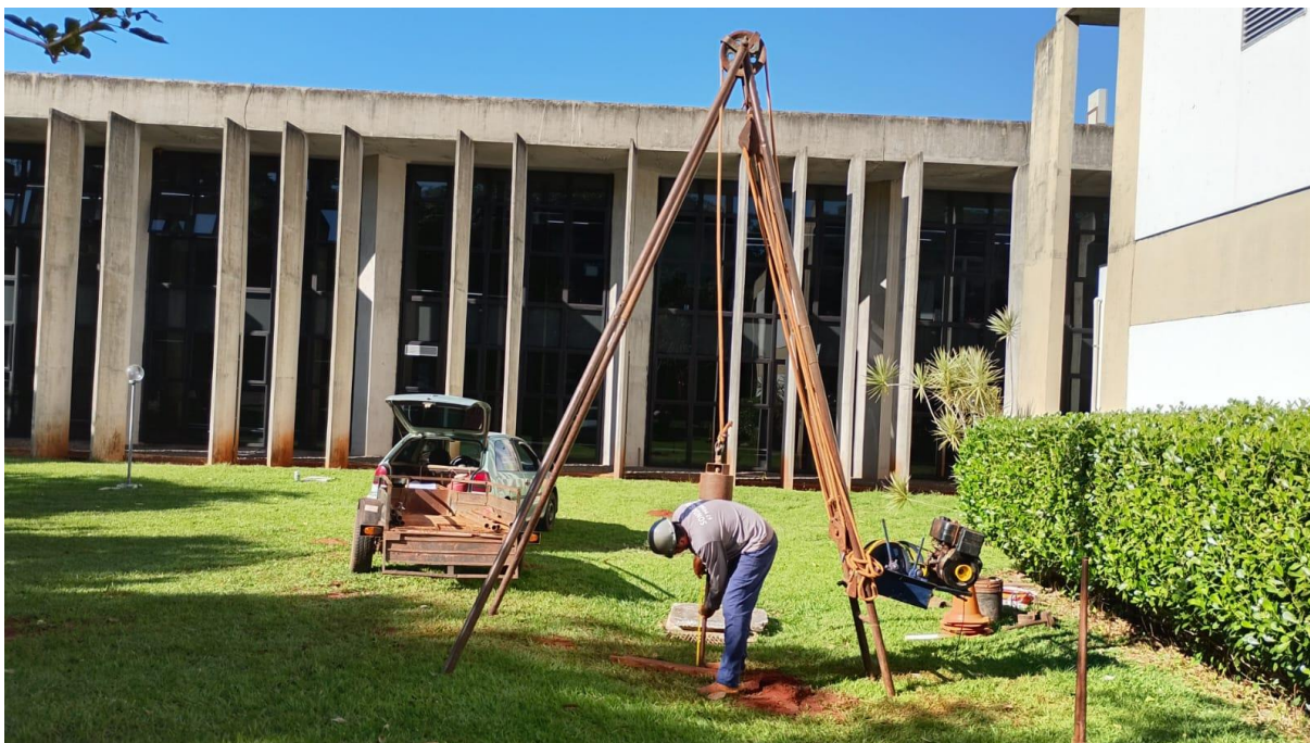
Figura 10 – Execução de sondagem SPT-04
