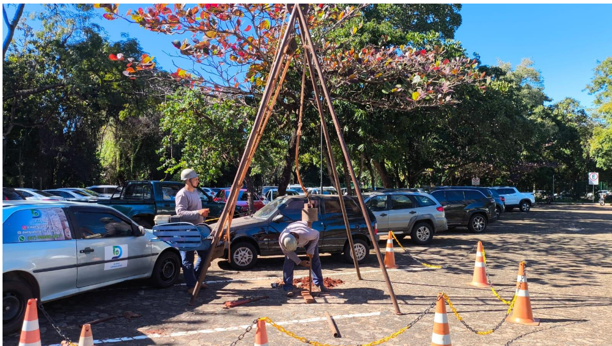
Figura 78 – Execução de sondagem SPT-14
