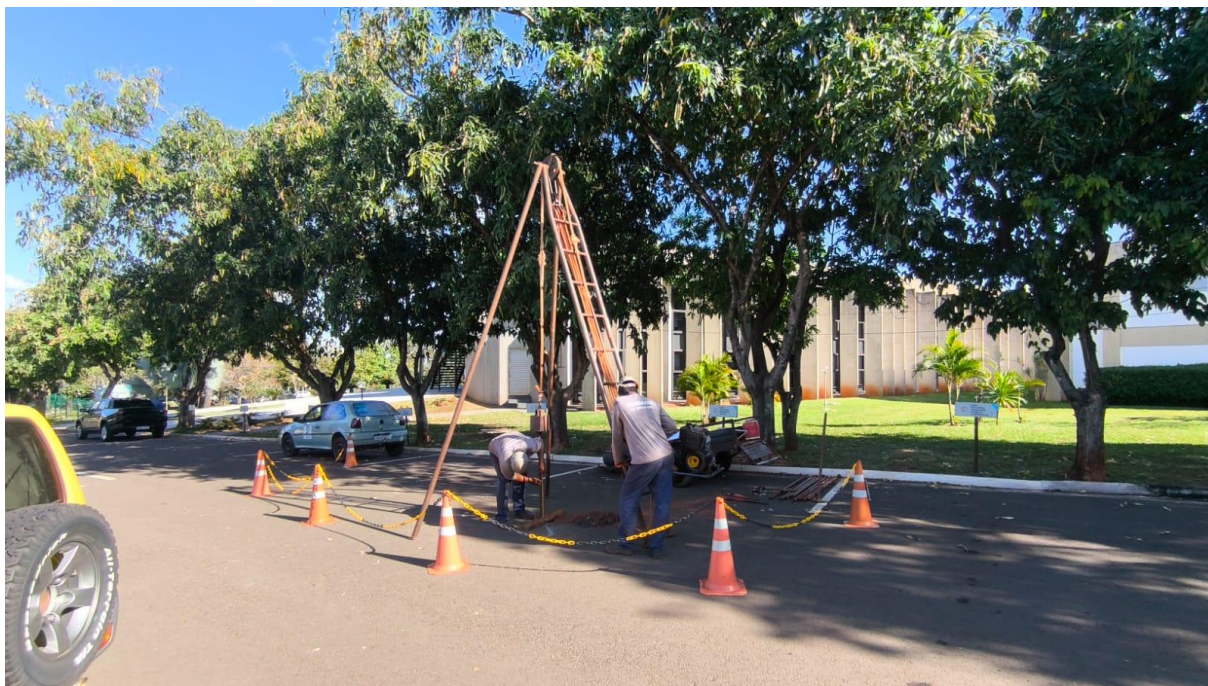
Figura 30 – Execução de sondagem SPT-07
