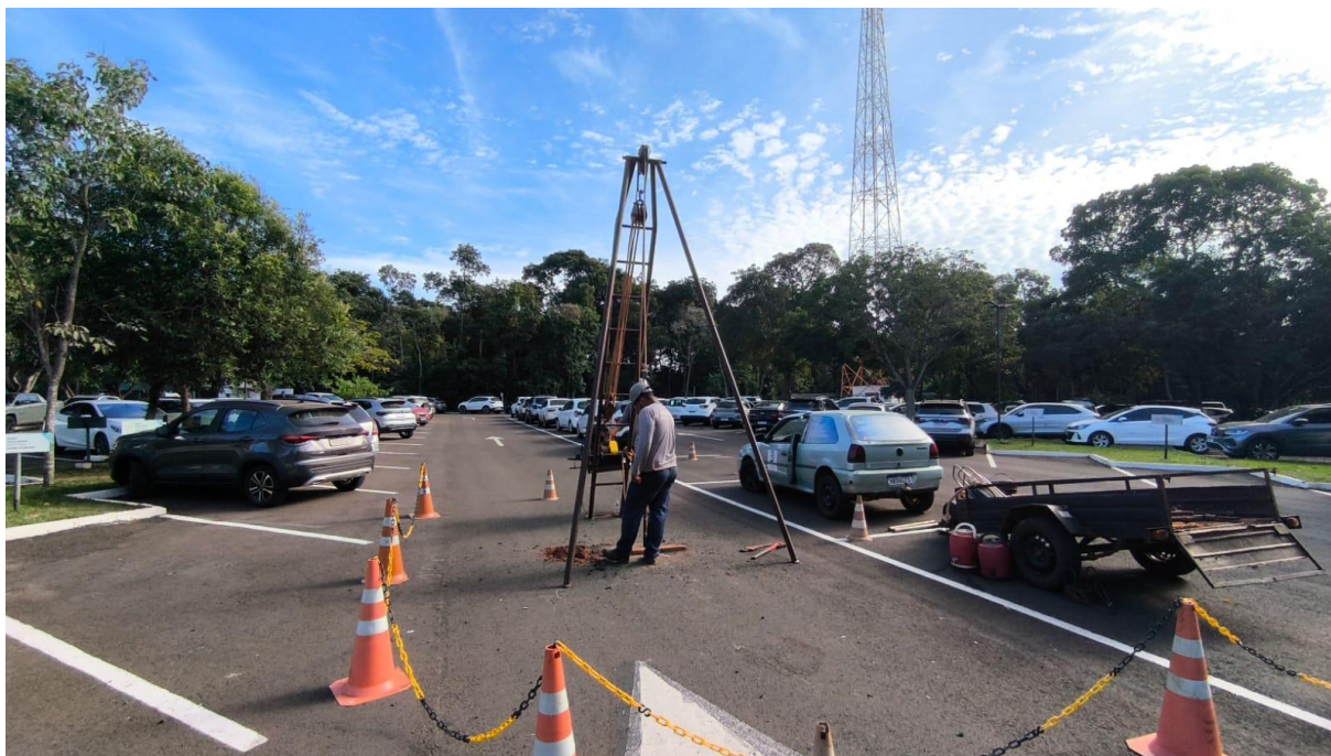
Figura 52 – Execução de sondagem SPT-10
