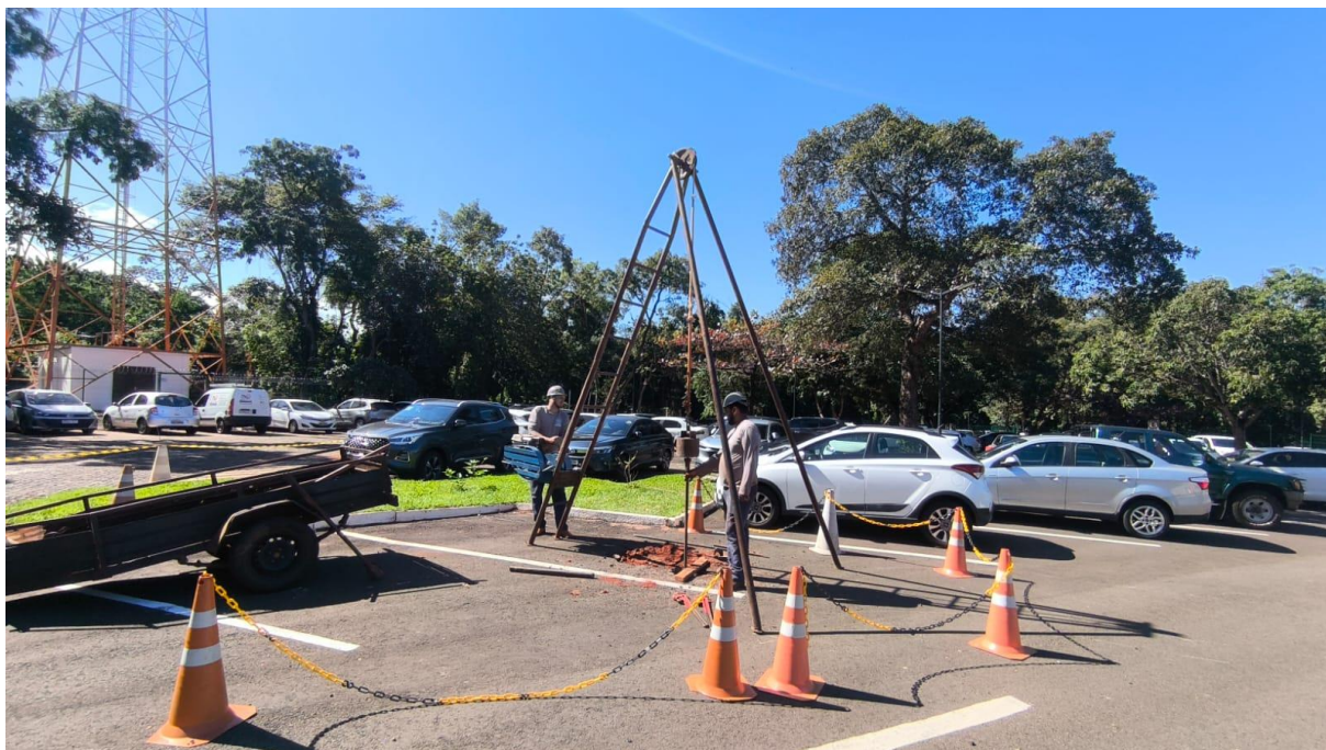
Figura 136 – Execução de sondagem SPT-22
