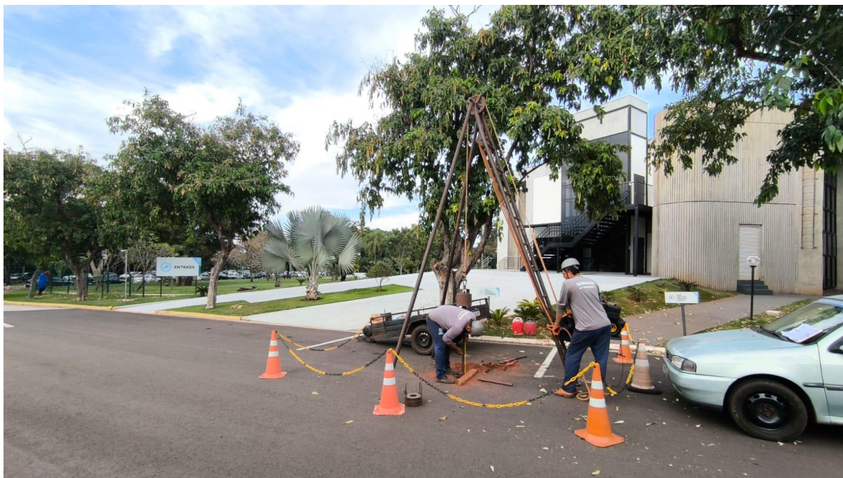
Figura 44 – Execução de sondagem SPT-09
