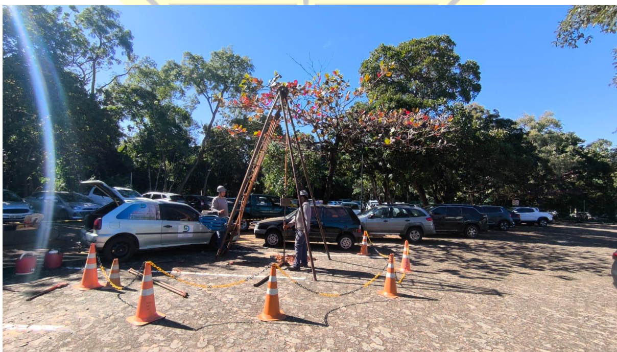
Figura 79 – Execução de sondagem SPT-14
