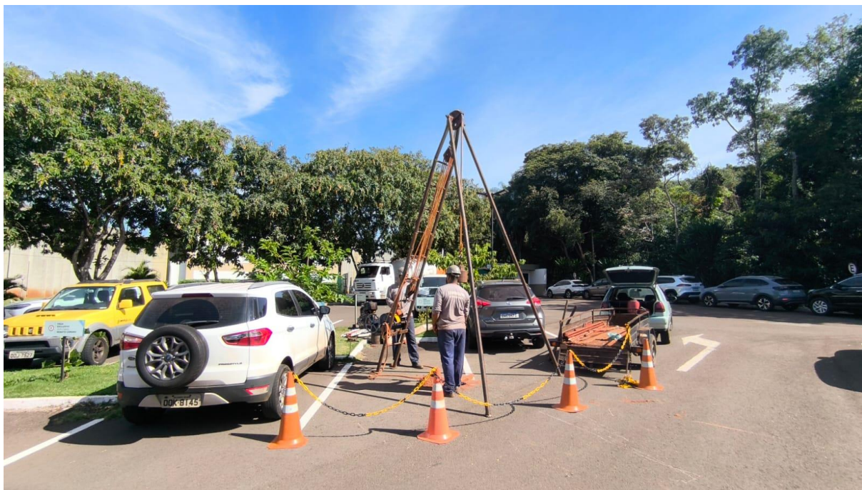
Figura 24 – Execução de sondagem SPT-06
