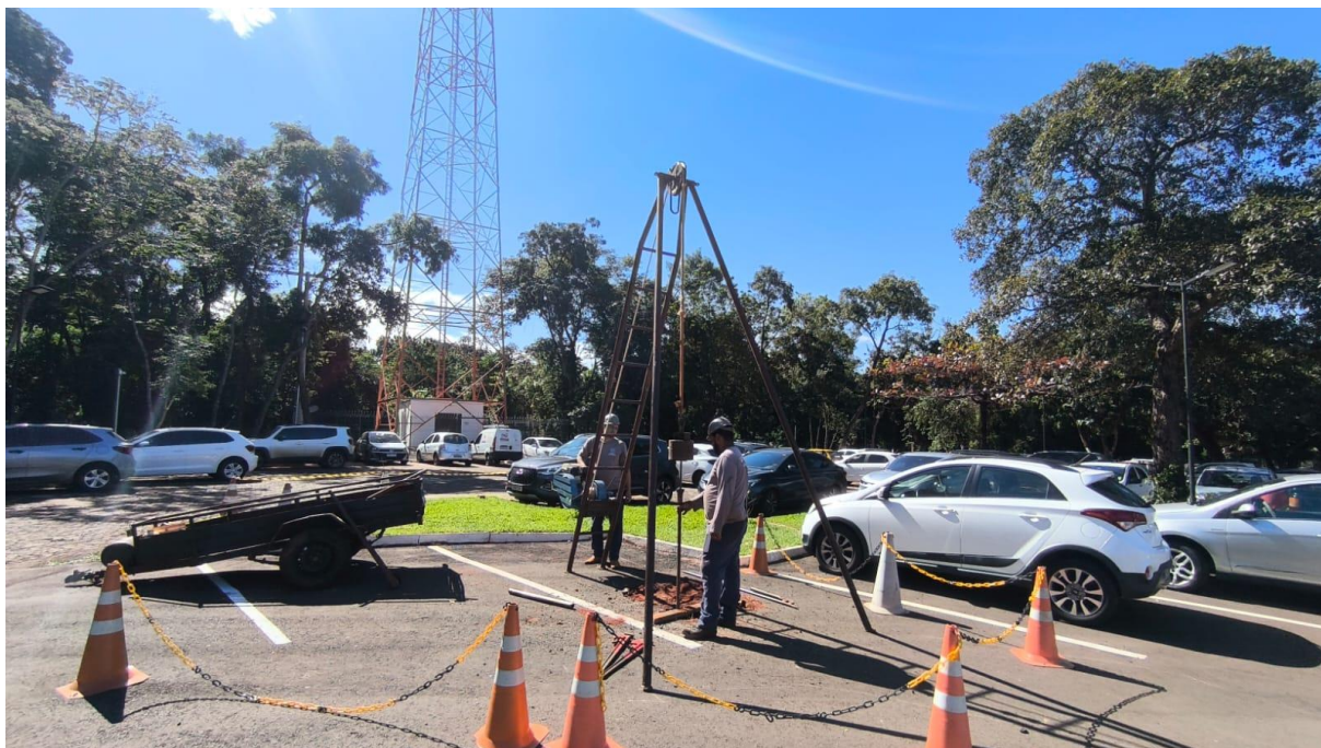
Figura 134 – Execução de sondagem SPT-22
