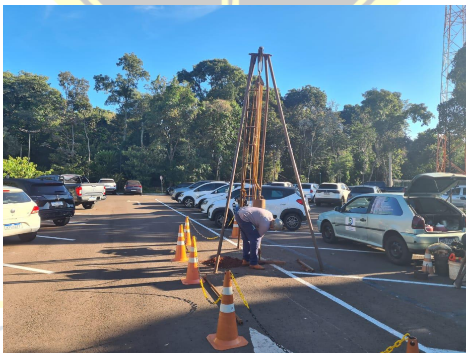
Figura 65 – Execução de sondagem SPT-12
