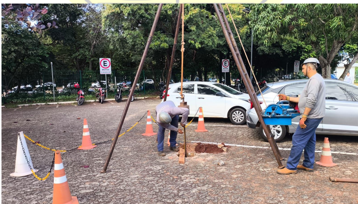
Figura 113 – Execução de sondagem SPT-19
