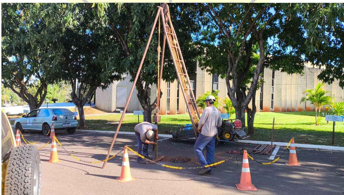
Figura 29 – Execução de sondagem SPT-07
