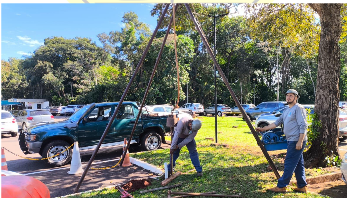
Figura 127 – Execução de sondagem SPT-21
