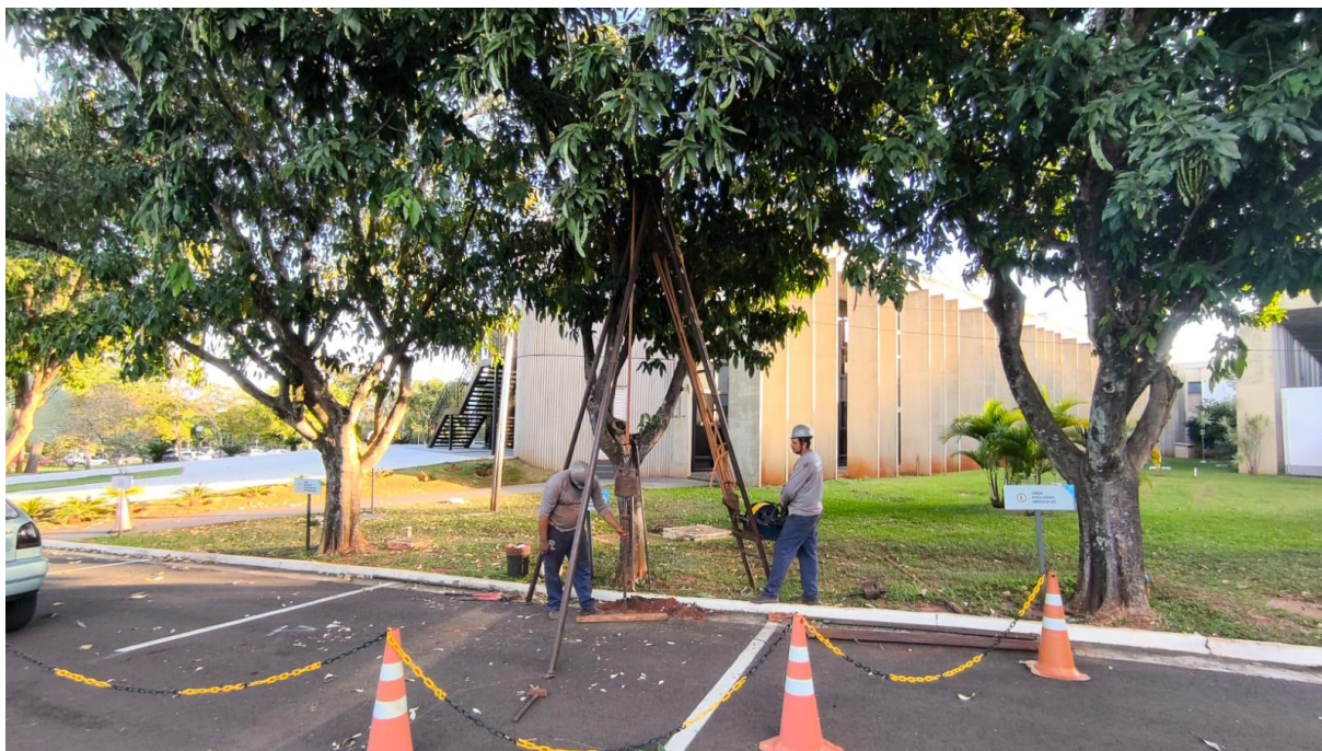
Figura 38 – Execução de sondagem SPT-08
