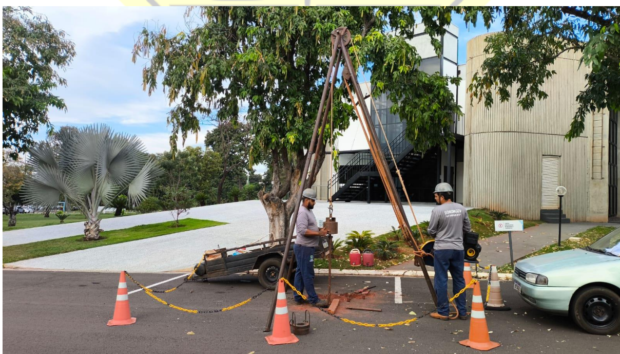
Figura 43 – Execução de sondagem SPT-09
