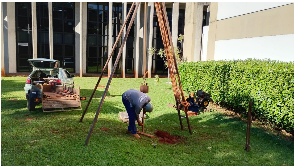
Figura 16 – Execução de sondagem SPT-05
