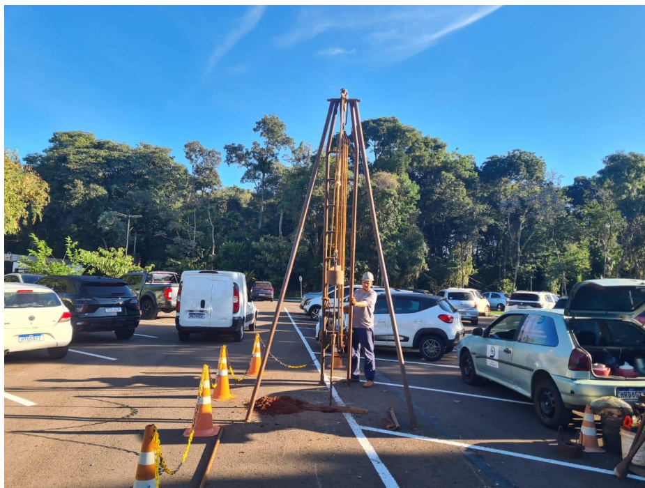
Figura 66 – Execução de sondagem SPT-12
