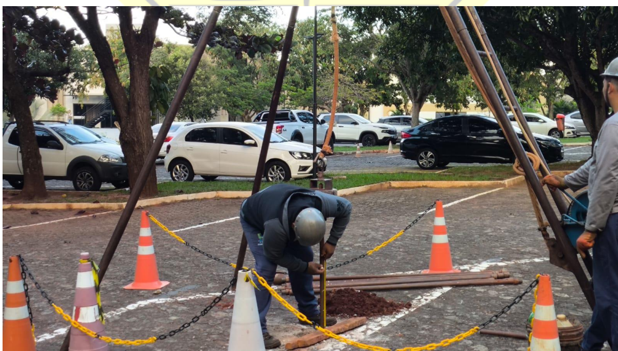
Figura 99 – Execução de sondagem SPT-17
