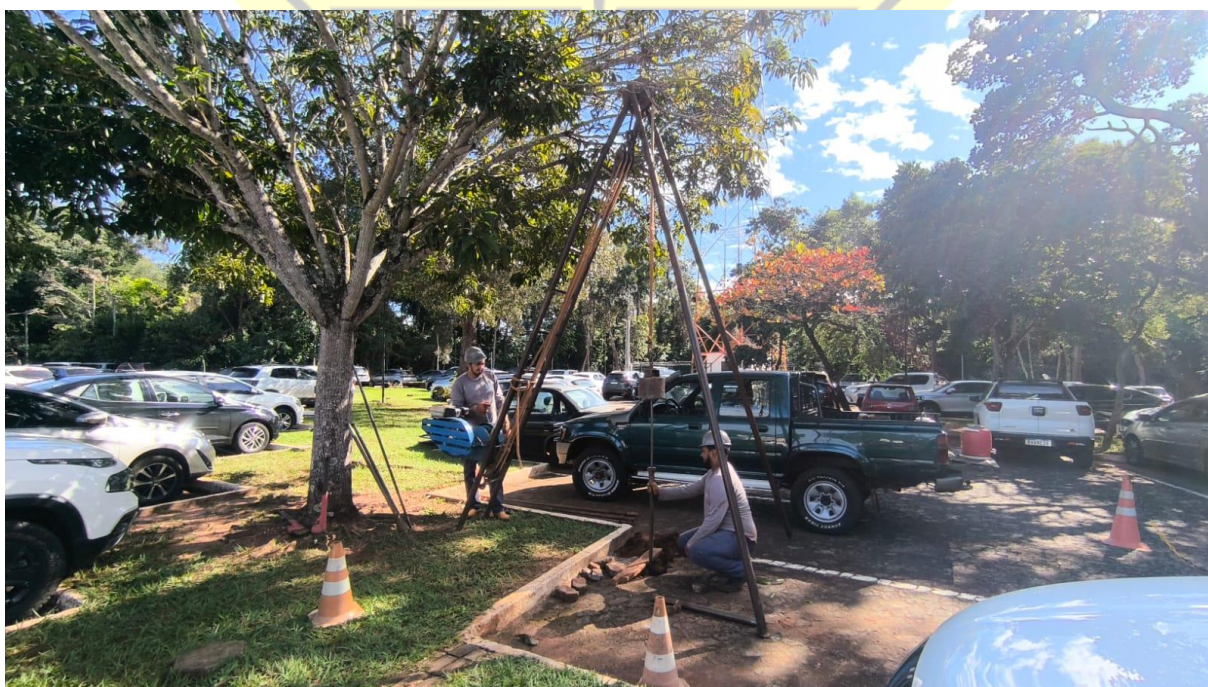
Figura 121 – Execução de sondagem SPT-20
