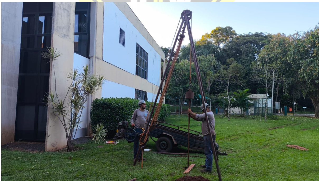
Figura 3 – Execução de sondagem SPT-03
