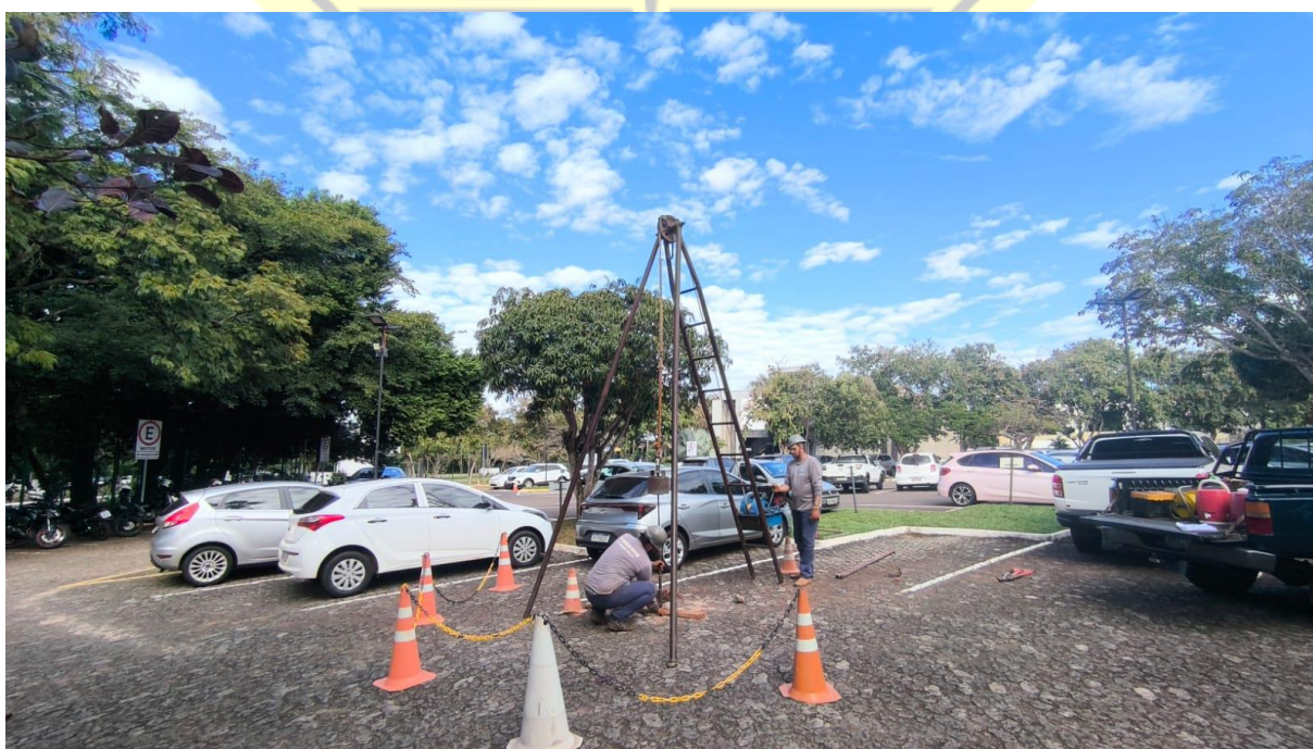
Figura 115 – Execução de sondagem SPT-19
