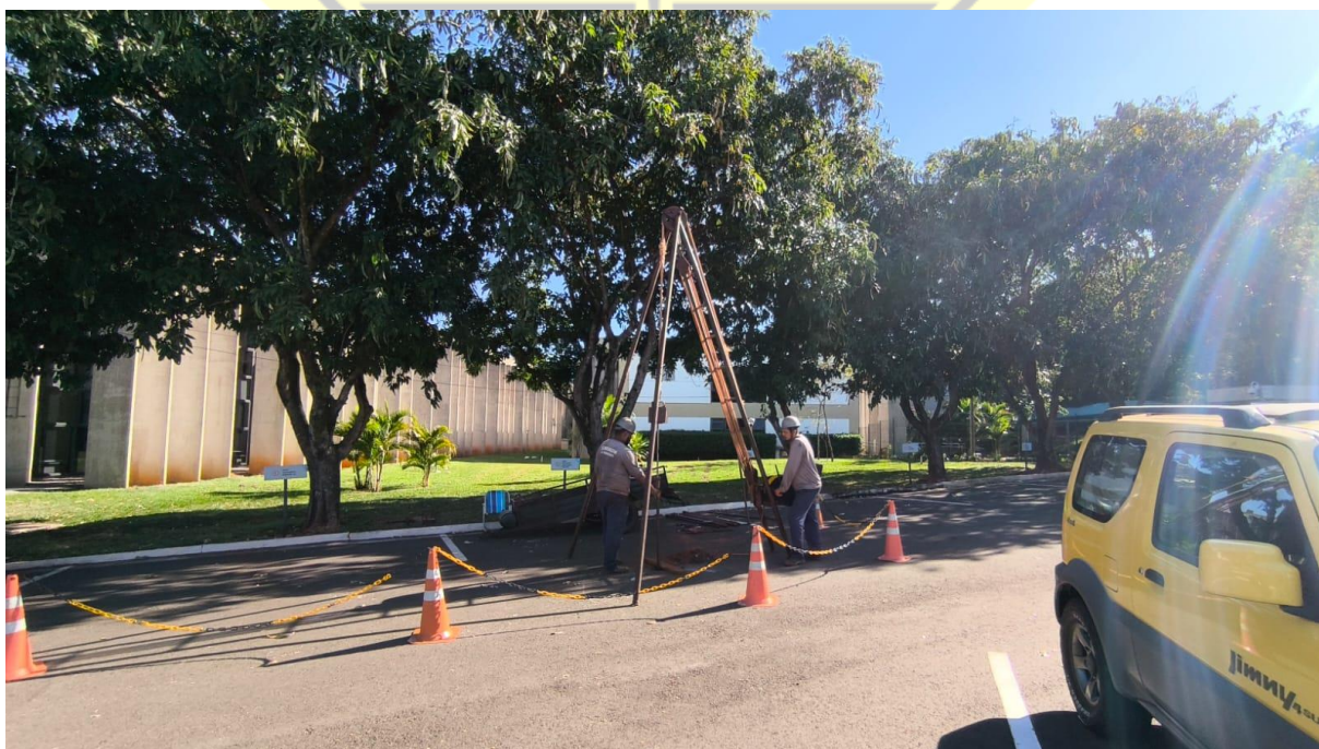
Figura 31 – Execução de sondagem SPT-07
