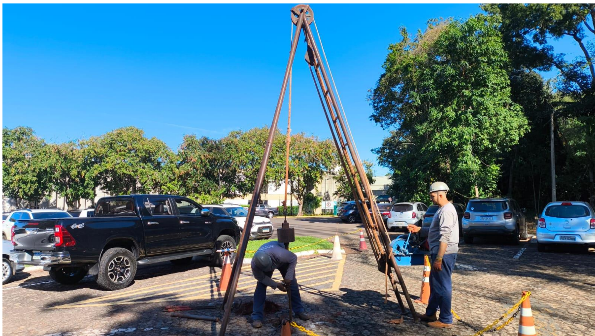
Figura 72 – Execução de sondagem SPT-13
