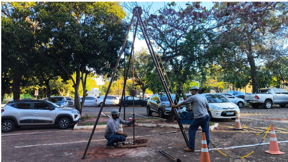
Figura 86 – Execução de sondagem SPT-15
