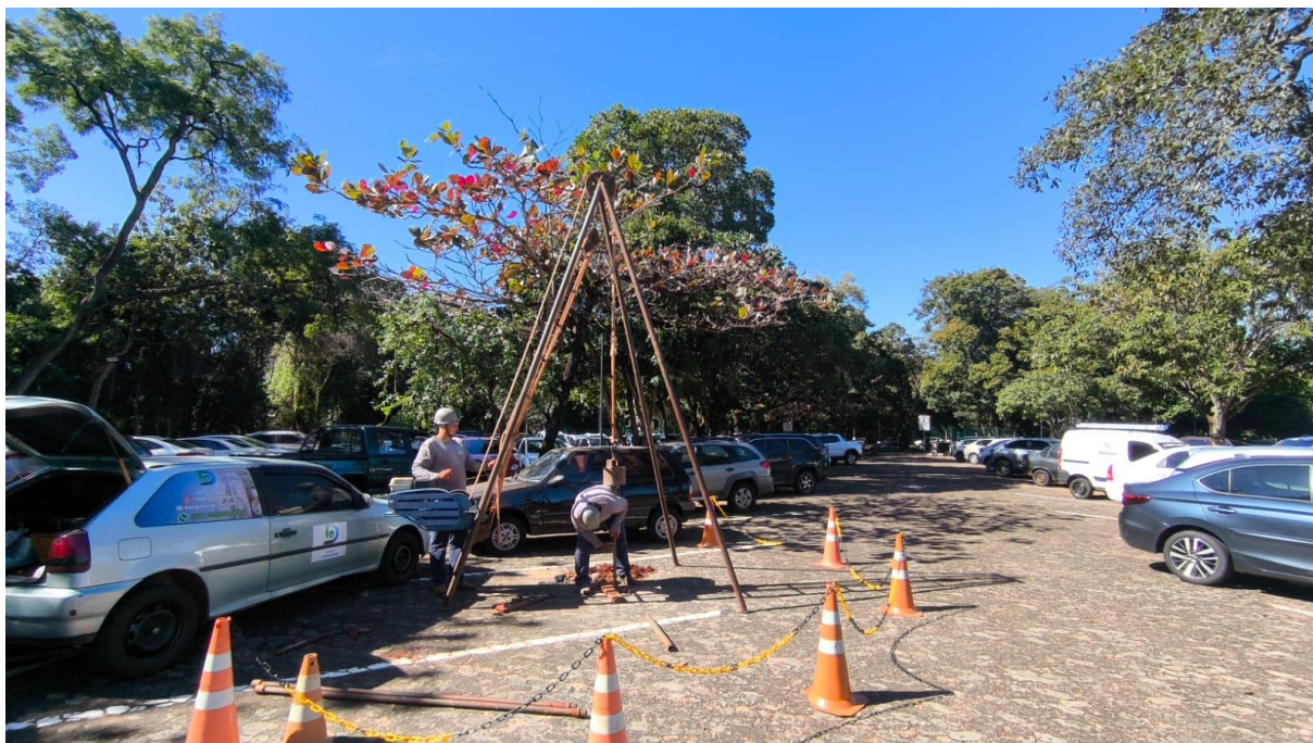
Figura 80 – Execução de sondagem SPT-14
