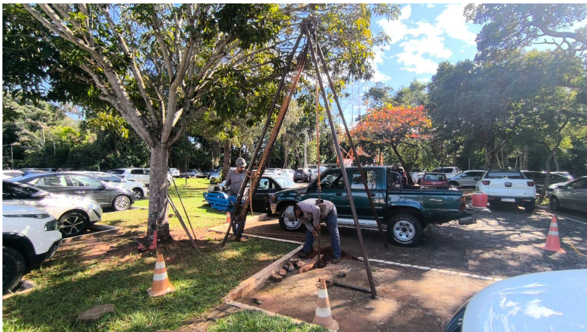
Figura 122 – Execução de sondagem SPT-20
