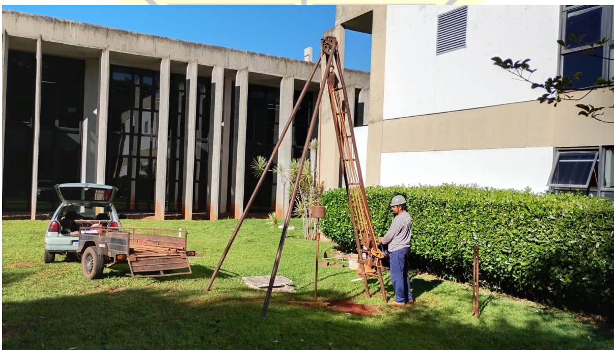
Figura 11 – Execução de sondagem SPT-04
