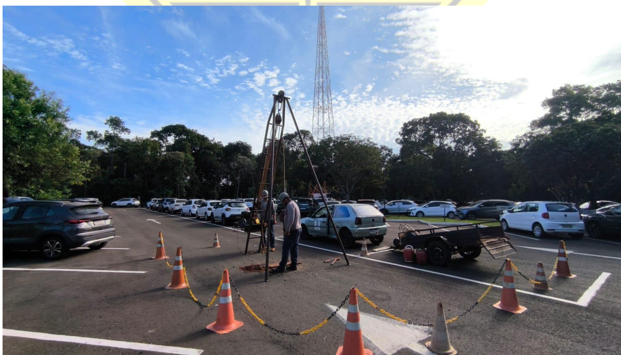
Figura 51 – Execução de sondagem SPT-10
