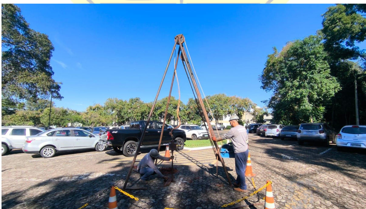
Figura 73 – Execução de sondagem SPT-13
