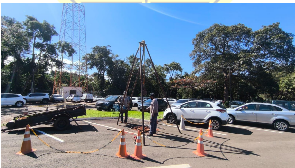
Figura 135 – Execução de sondagem SPT-22
